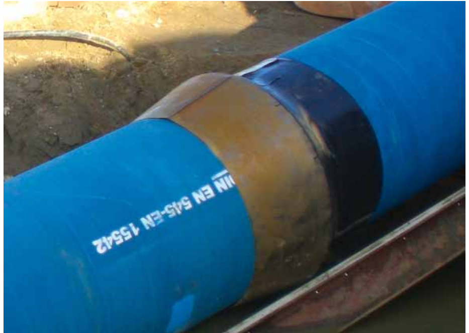
Bild 9: Verbindungsschutz Schumpfmaterial mit übergeschobenem Blehkegel
