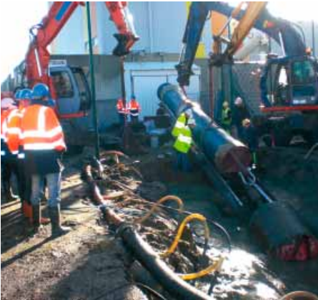
Bild 6: Rohrmontage auf Montagerampe
