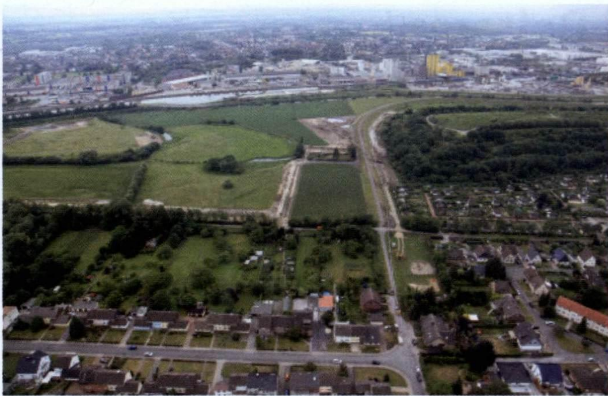
Die Baustelle aus der Luft: In der dicht besiedelten Gegend an der Speicherstraße des Ruhrgebiets verlaufen der Datteln-Hamm-Kanal und der Fluss Lippe parallel zueinander. | Foto: Visser&Smit Hanab GmbH
