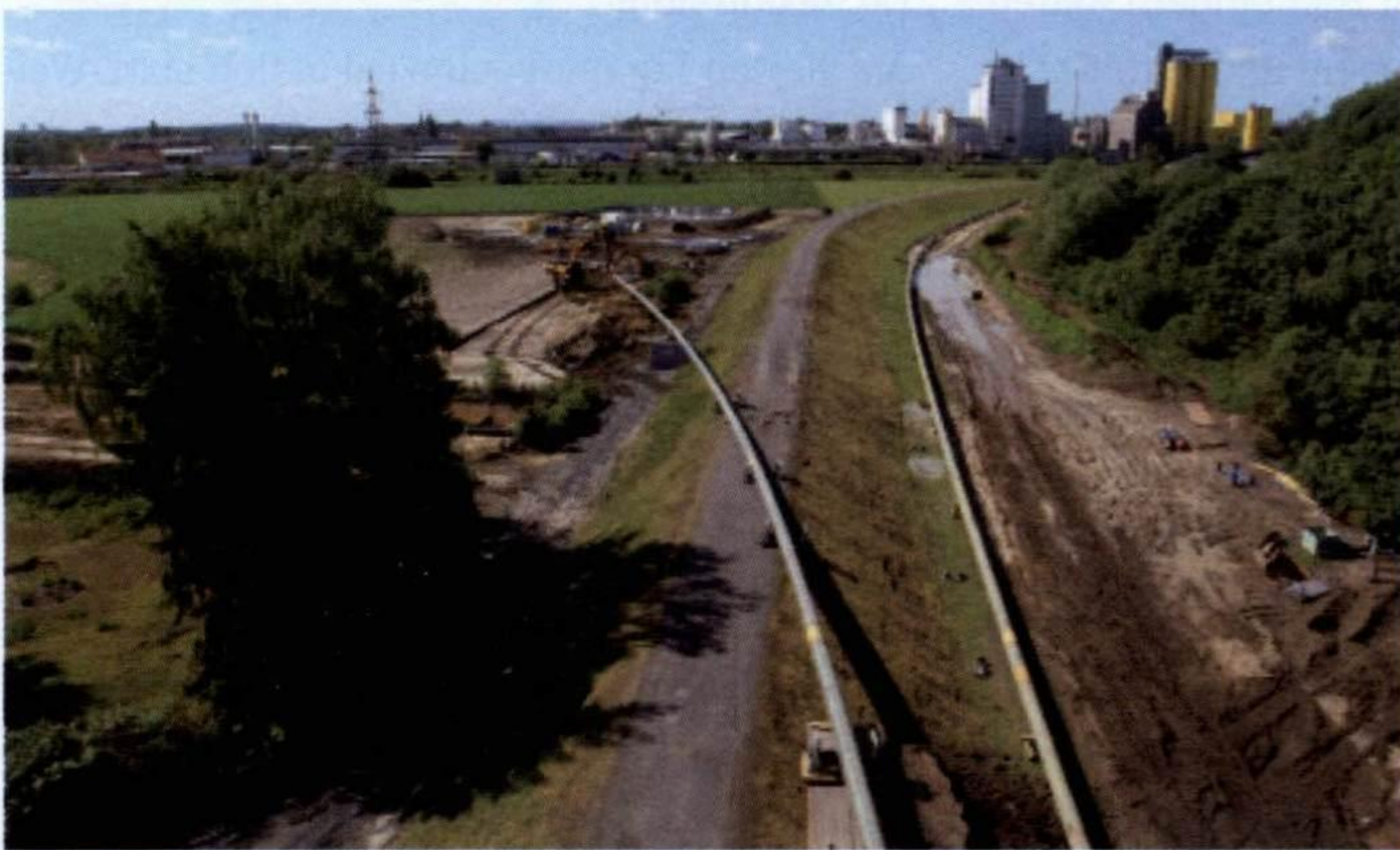
Bei der Unterführung des Datteln-Hamm-Kanals wurden drei Bohrungen von jeweils 420 Metern Länge vorgenommen. | Foto: Visser&Smit Hanab GmbH
