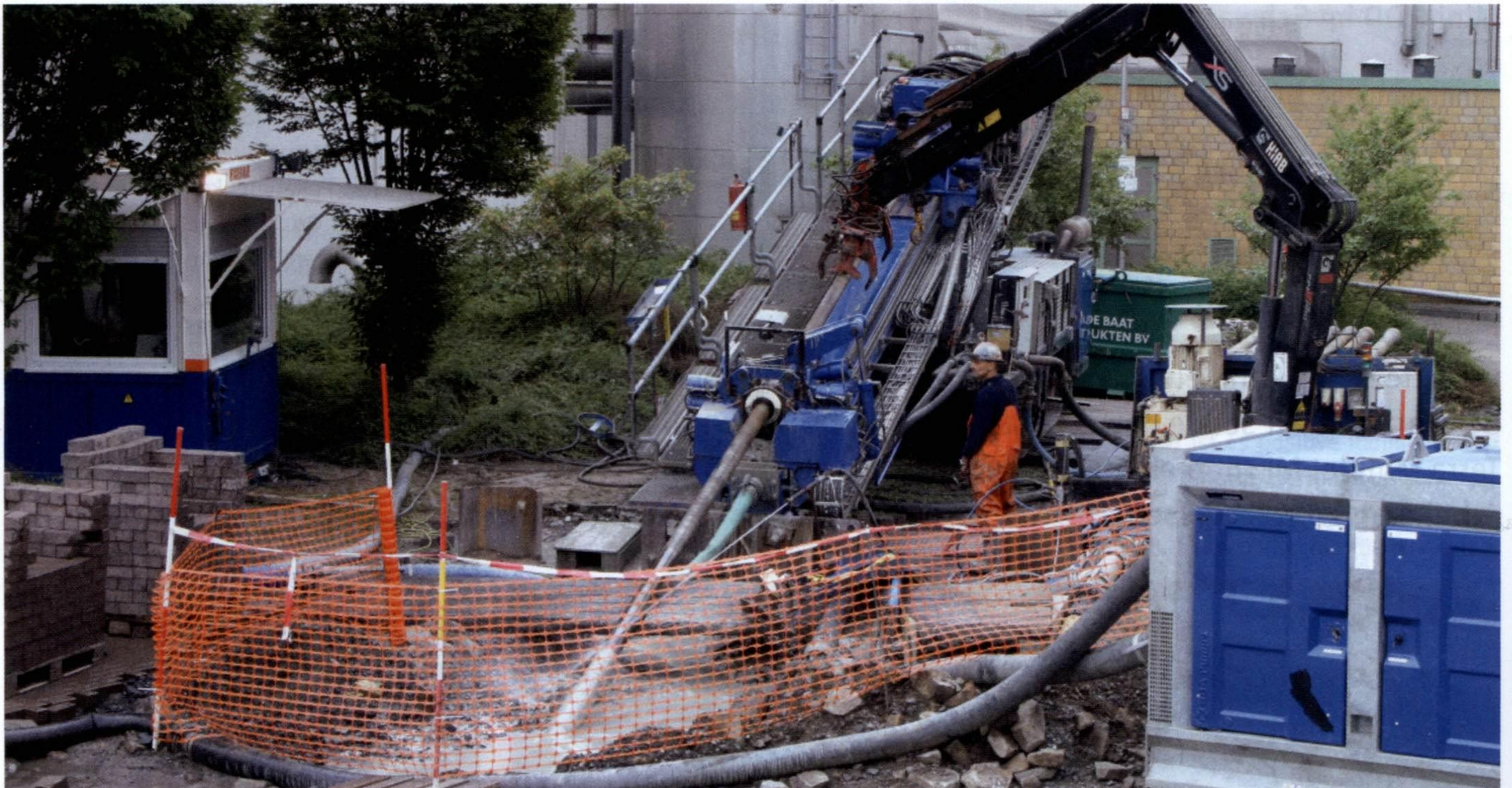
Die in Hamm eingesetzte Bohranlage PD100/50RP mit einer Zugkraft von 1.000 kN. | Foto: Prime Drilling
