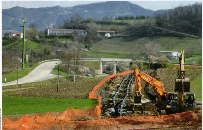
▲ Abb. 2 – Rohrtrasse mit zwei vorbereiteten Rohrsträngen
