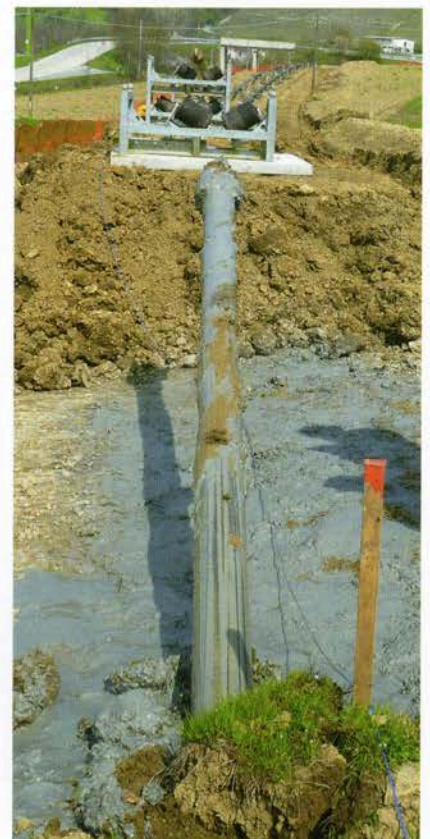
Abb. 5 – Der geplante Austrittspunkt der Bohrung wurde zielgenau getroffen.
