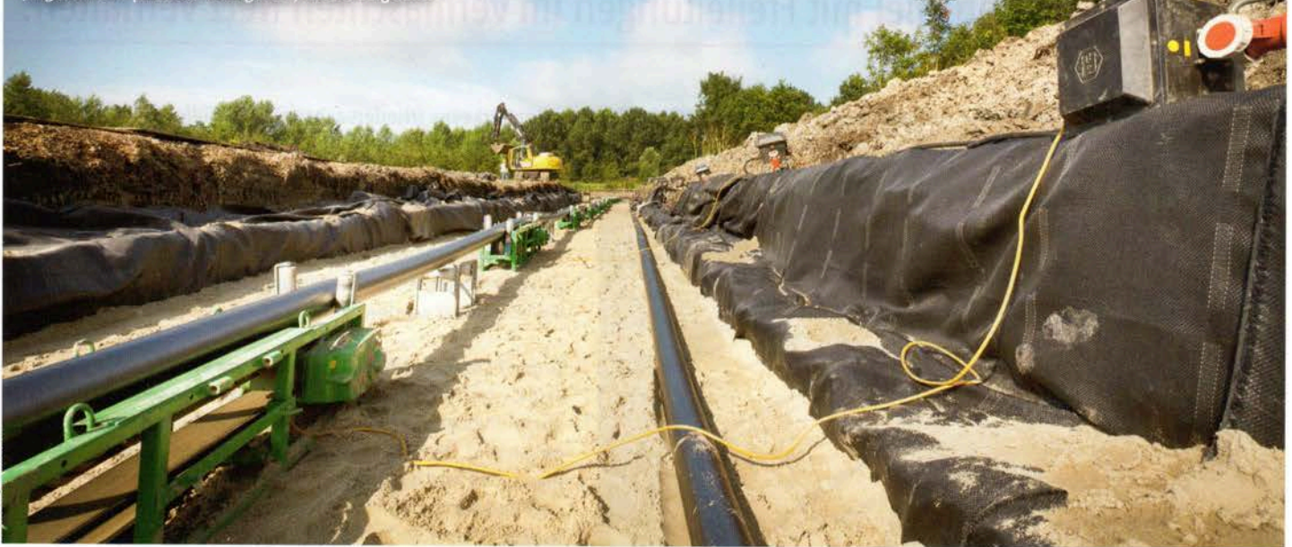
Abb. 1 – Die Kabel werden mit einem Spezialtransport auf Kabelrollen angeliefert und in den offenen Gräben gelegt. Anschließend wird auf den Rohren ein Geotextil aufgebracht. Danach werden die Gräben mit Sand (ungefähr 3 m 3 pro Meter Kabelgraben) wieder aufgefüllt.
