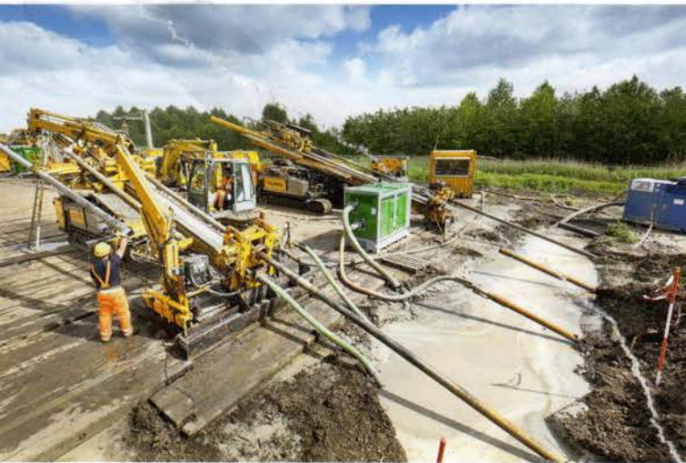
Abb. 2 – Unter Gebäudezeilen, Autobahnen und Bahnstrecken werden die Kabel mithilfe einer gesteuerten Bohrung verlegt.
