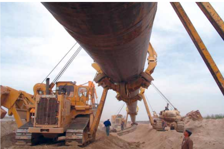
Zu verlegen war ein Stahlrohr mit einem Durchmesser 1042 mm und einer Länge von mehr als 1000 Meter.
