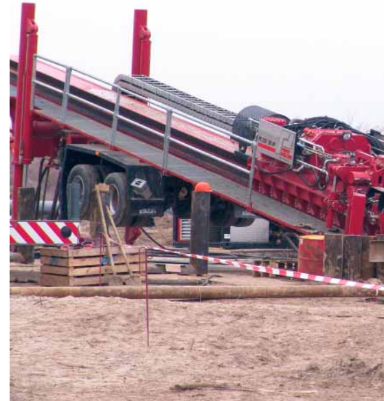
Zum Einsatz kam ein Bohrgerät mit einer Rückzugskraft von 250 t und einem Drehmoment von 90.000 Nm.
